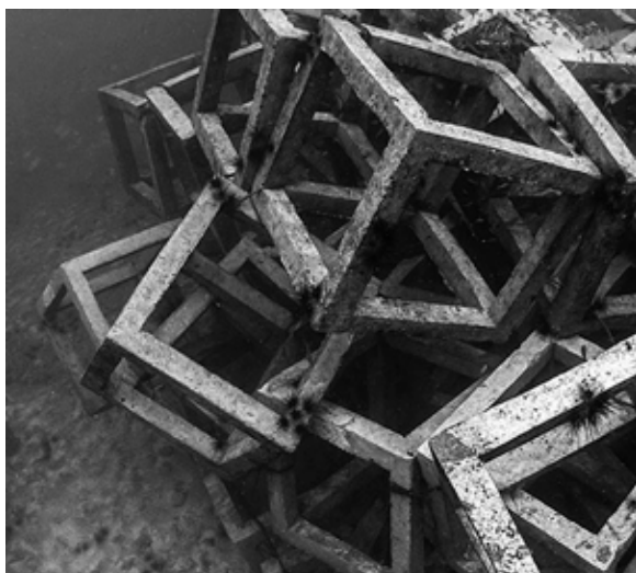
Slika 6: Umjetni greben od masivnih A-B elemenata
