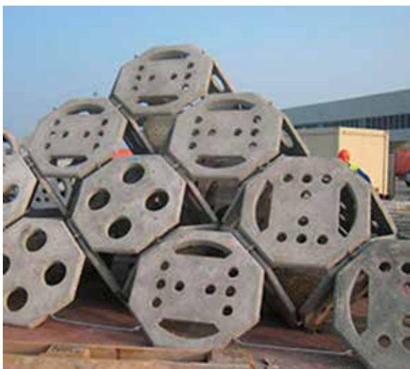
Slika 5: Betonski elementi za formiranje umj.grebena
