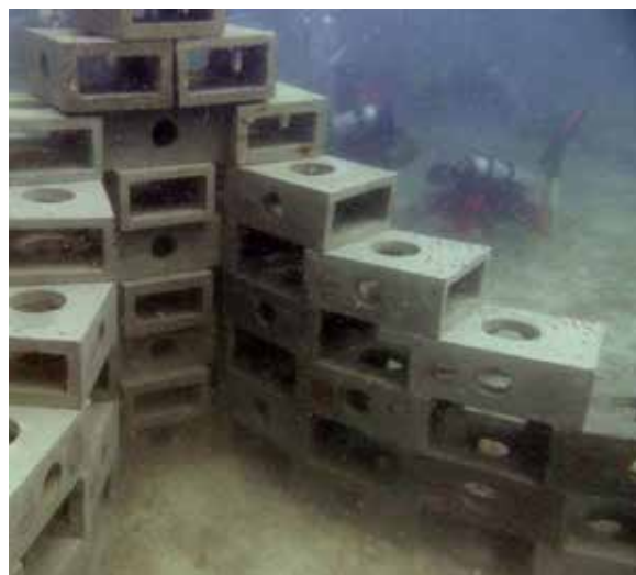
Slika 8: Betonski elementi za formiranje umj.grebena
