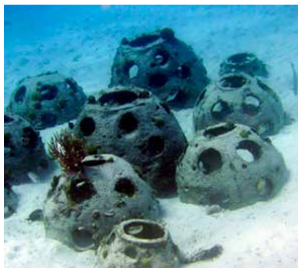
Slika 4: Umjetni greben od betonskih elemenata
