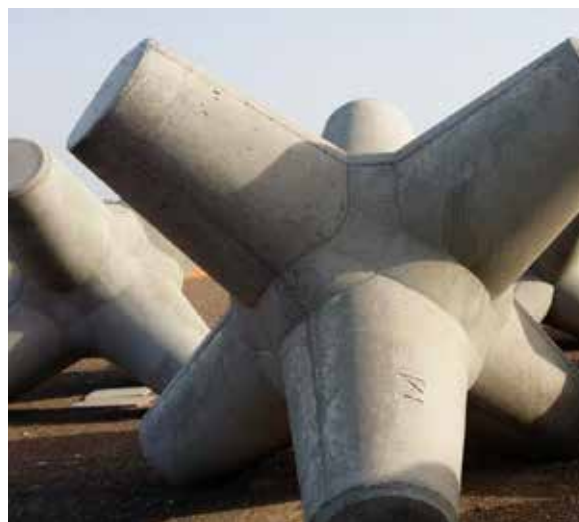
Slika 10: Betonski elementi za formiranje umj.grebena
